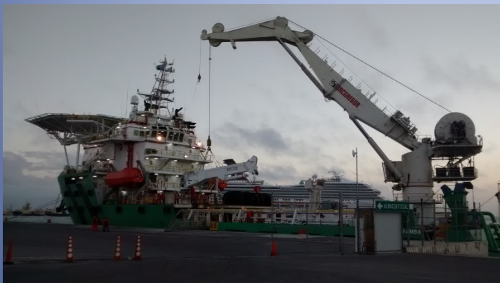
Instalación de Grúa Auxiliar de 50 toneladas aprobada por ABS.
